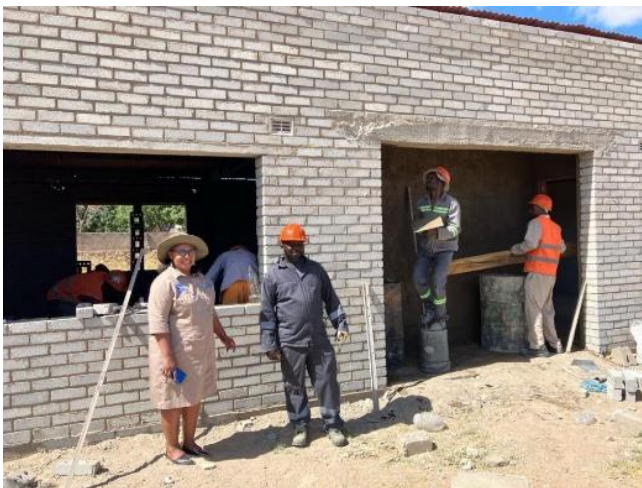
Figuur 3: Twee nieuwe lokalen in aanbouw in Cowdray Park Projects Centre
