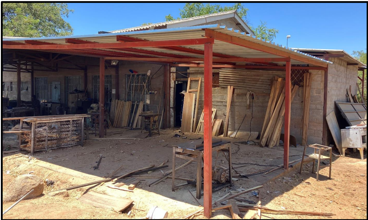
Figuur 2: Constructie van een overkapping voor houtbewerking activiteiten
