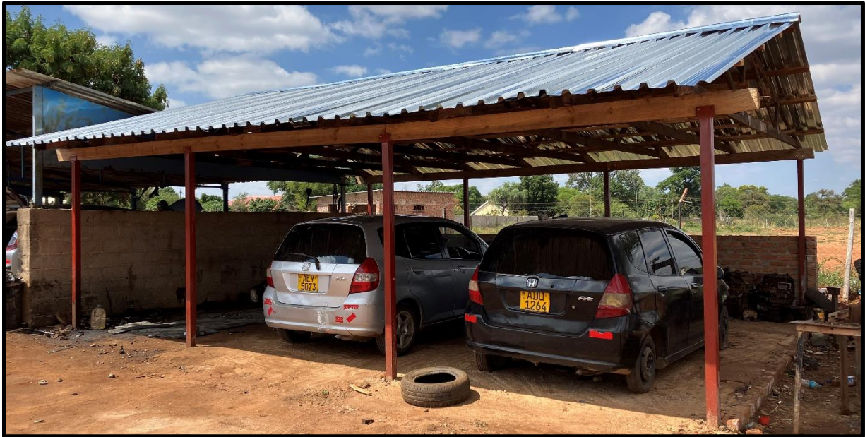
Figuur 11: Constructie van een overkapping voor de training van leerlingen autotechniek
