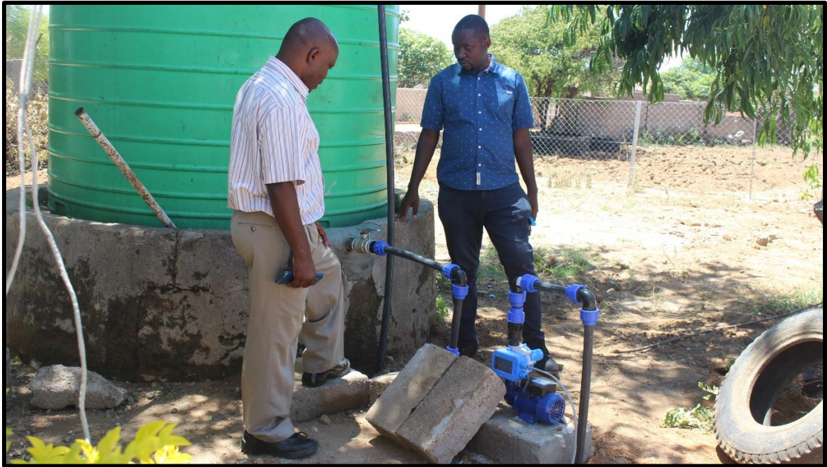
Figuur 3: Aanleg van een boorgat met waterreservoir voor de modeltuin
